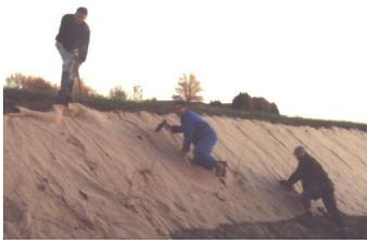
Lorsque la pente est trop forte, l'emploi d'un tissu en fibre végétale joue un double rôle de maintien de la terre et de paillage des végétaux.
