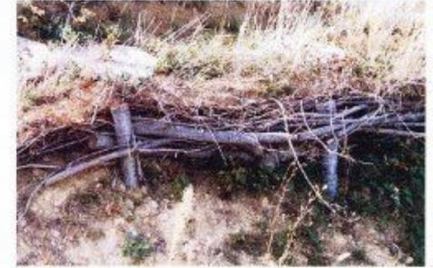
Sur les talus trop hauts, la réalisation d'un fascinage par implantation de pieux et tressage de branches sur ces piquets permet de tenir mécaniquement la terre.
